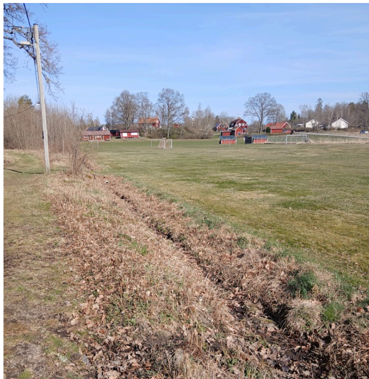
Diket i anslutning till Sätervallen. Kulvertering syns på bild.
