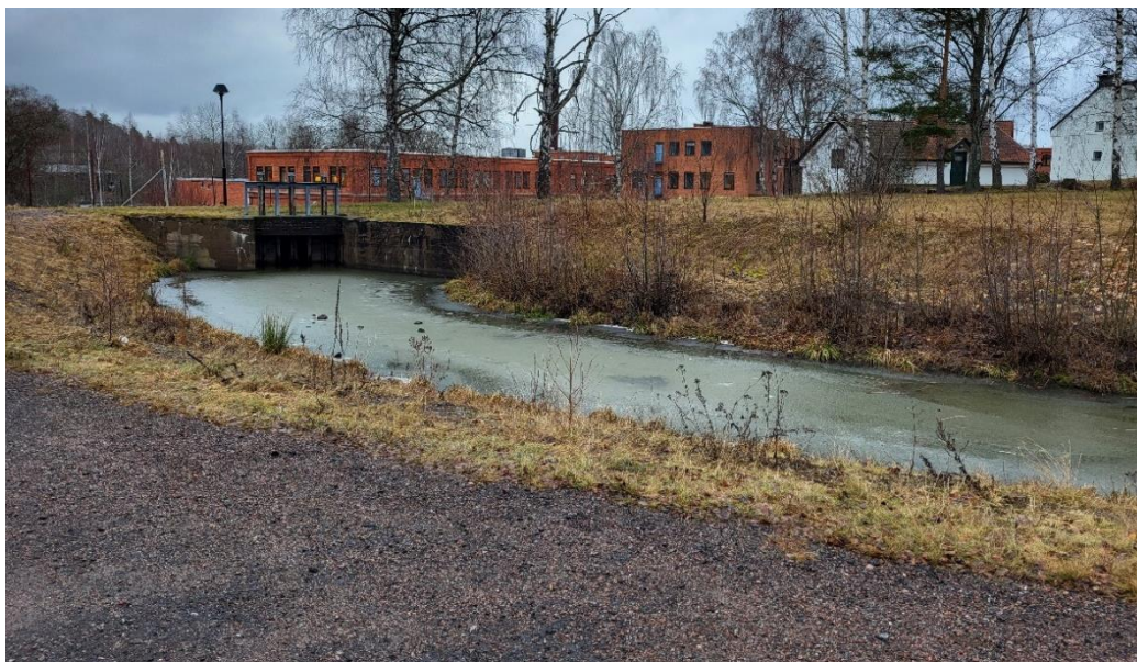
Figur 6. Fotot visar närheten mellan parkeringsytan och kraftverkskanalen.
