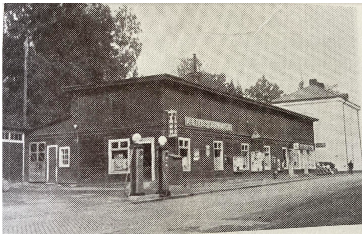
Fotografi från när byggnaden var bensinstation. Foto: Okänd.
