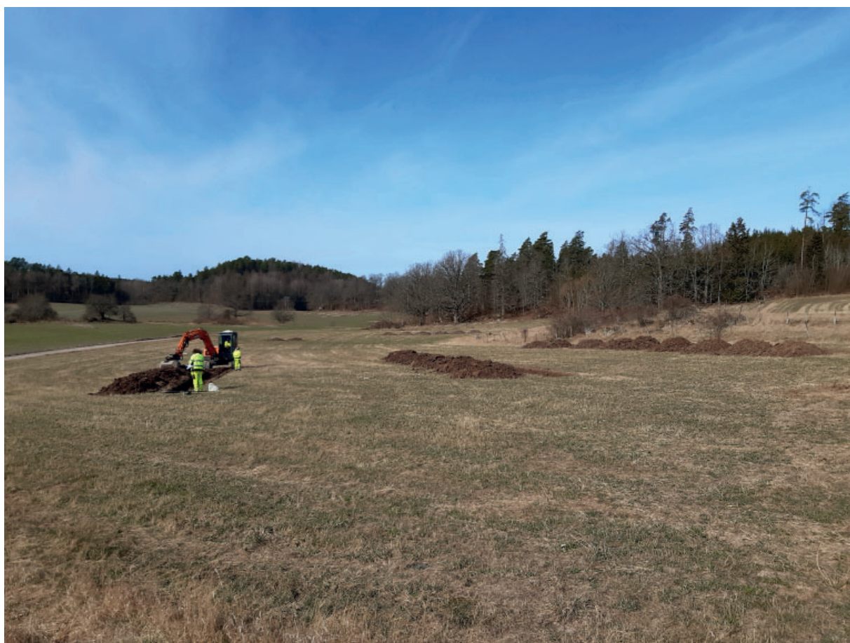
Fig. 4. Sökschaktning med grävmaskin inom delområde D.
