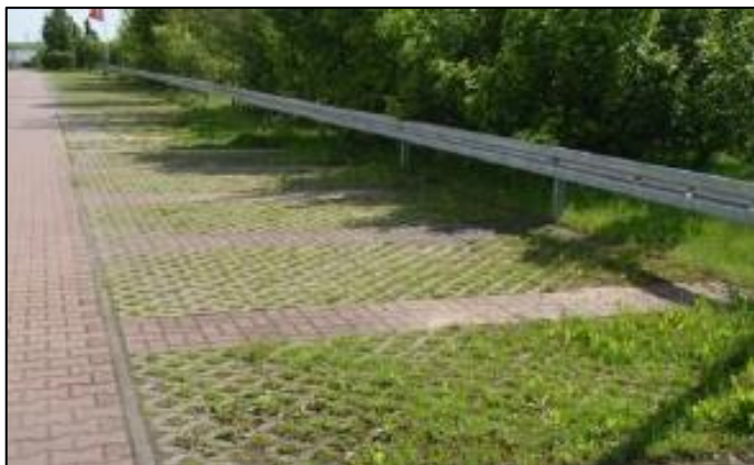
Figur 31. Exempel på genomsläpplig beläggning med gräs.
